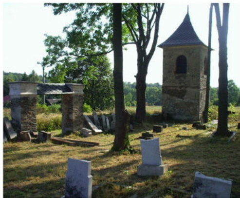
Zvonička má novou střechu, schodiště a vstupní dveře, které se už dají zamykat
