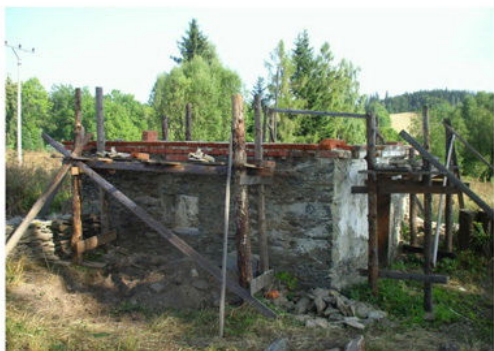
oprava bývalé márnice v letošním roce
