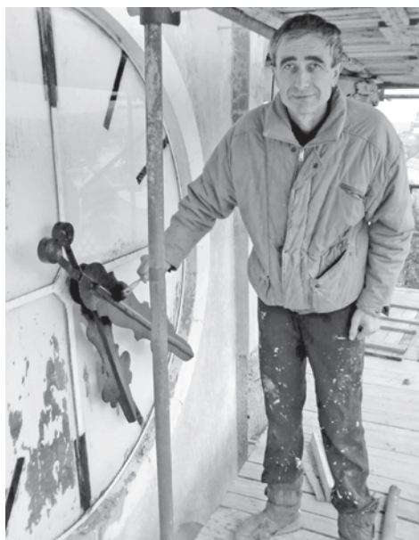
● Jiří u hodin při opravě věže kostela.
