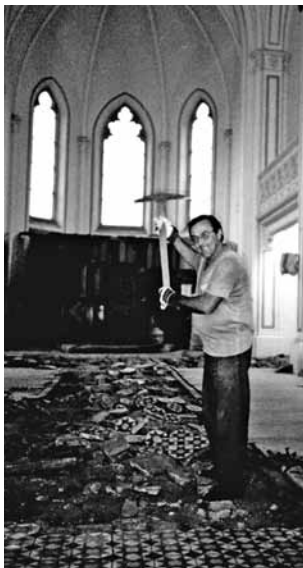
● 1998 - Luboš pomáhá při odstraňování povodní poškozené podlahy v kostele
